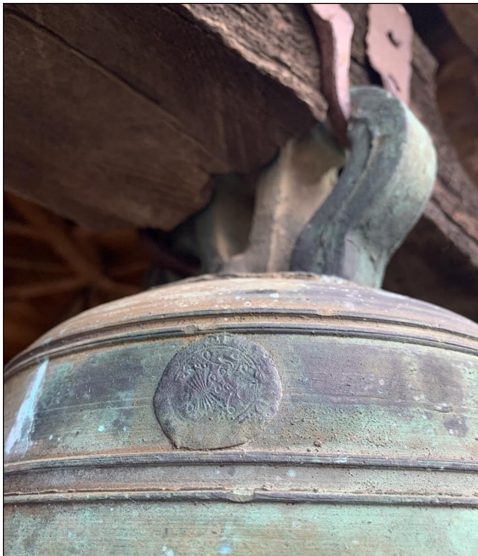
Fig. 9. Yugo de madera, herraje y asas de la campana esquilonada en El Rebollar (Burgos), con una impronta de una moneda de un real de los Reyes Católicos, acuñada en la ceca de Sevilla y levemente girada a la izquierda (12-02-2022).
